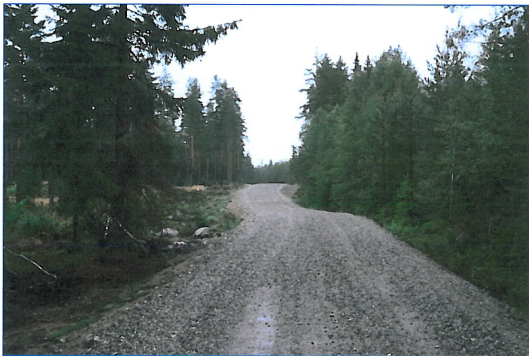
Bild 2 Färdig väg till ett vindkraftverk, från Eolus Vind AB vindkraftpark Vettåsen, Sandvikens kommun.
