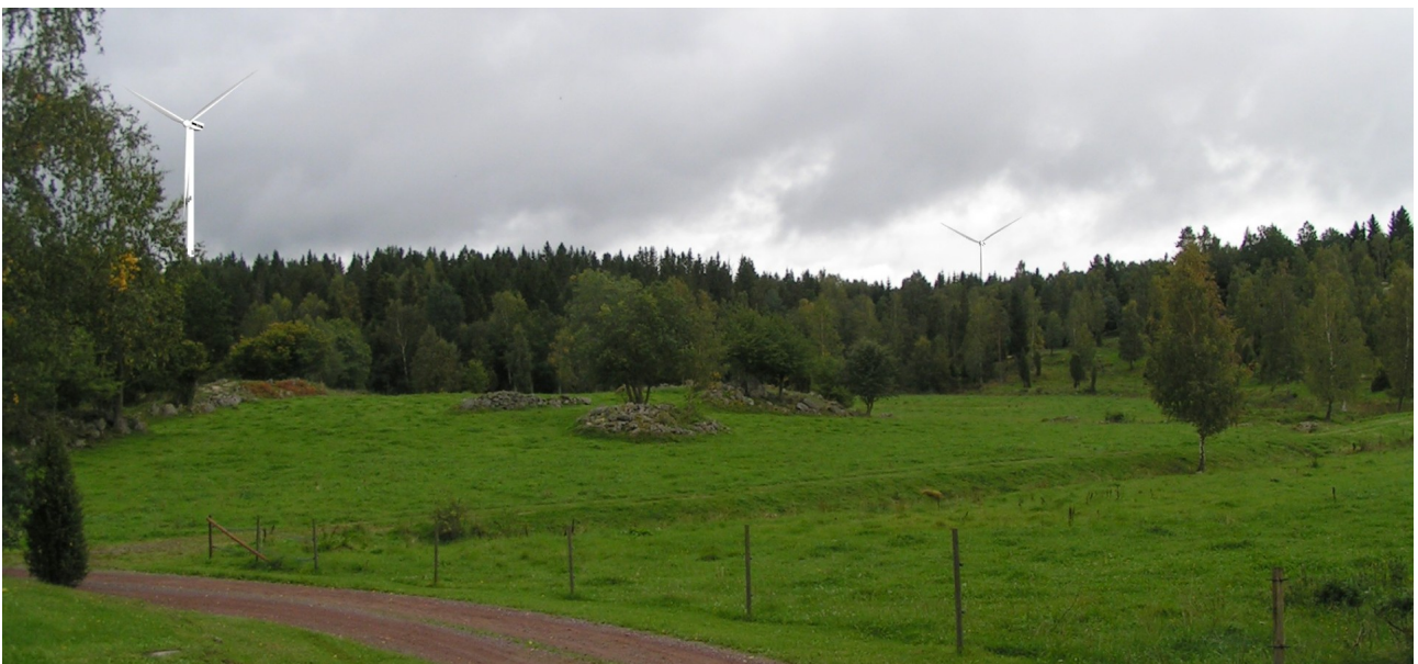
6 Visualisering från Lakarp: till vänster: det nordöstra verket, till höger: det södra verket. (200 m.ö.h.)
