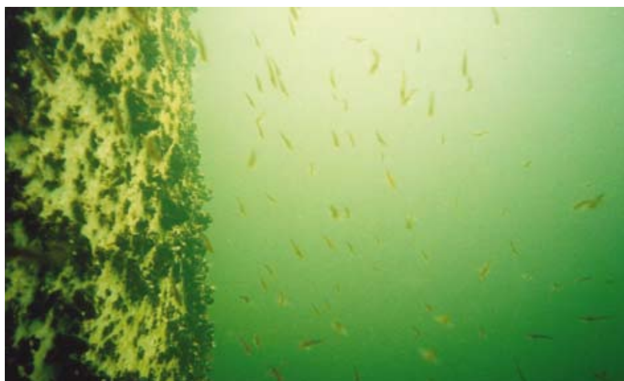
Vindkraftsverkets betongfundament inklätt i blåmusslor och simmande sjustrålig smörbult. Foto: Dan Wilhelmsson.
