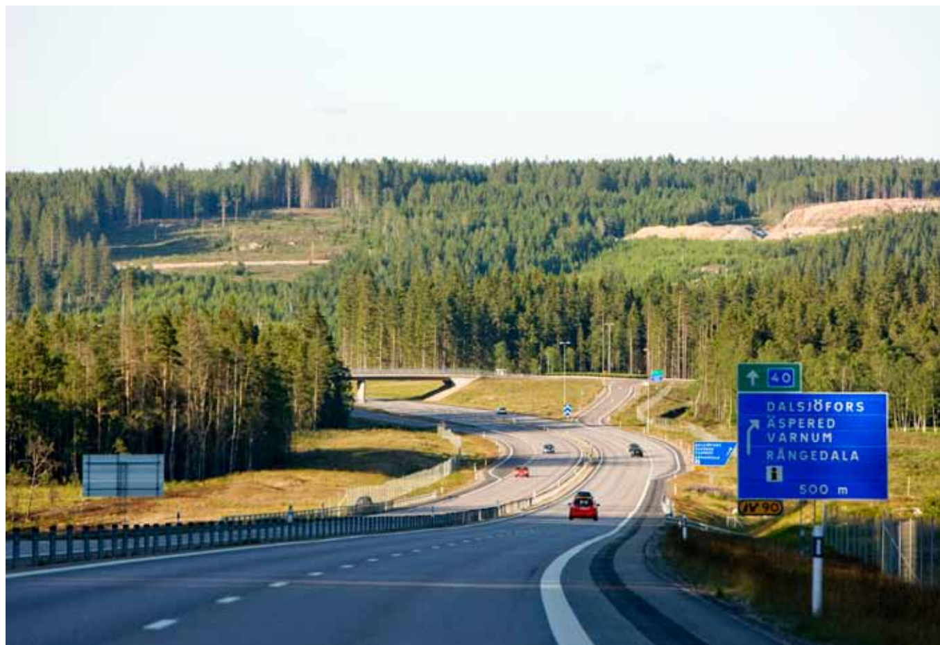
Bild 70. Sjuhäradsbygdens topografi är svår. En väg kan delvis följa terrängens former, men järnvägen är alltför stel. Broar eller bankar blir ofta följden.
